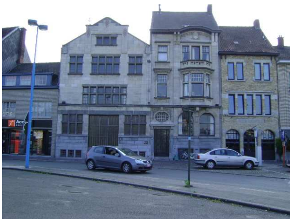
Beschermd monument magazijn en art-deco herenhuis, Stationsplein 31-32
