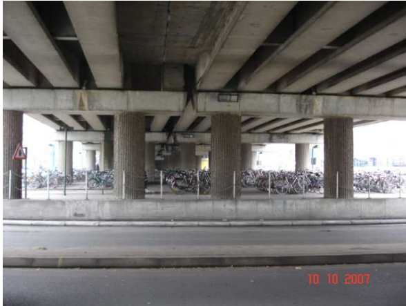
Fietsenstalling onder spoorwegviaduct, naast Sint-Amandsstraat
