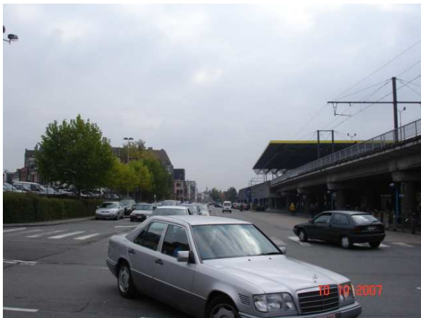
Jules Lagaelaan gezien vanaf de Sint-Amandsstraat met rechts spoorwegberm en dak van het station en links kleine pendelparking met groene inkleding
